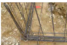
Noeud de chaînage - Continuité mécanique
